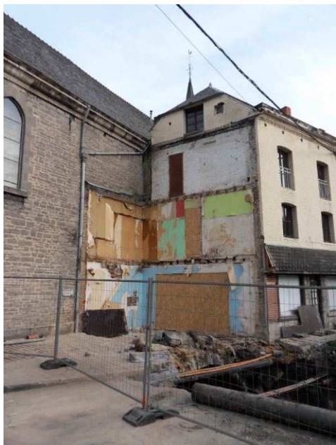
Chantier (Photo E. PHILIPPE © 2015)
