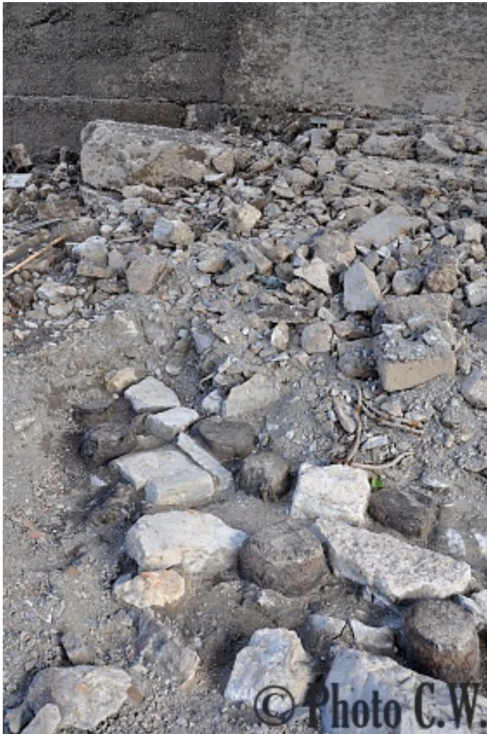
Rangée vers le nord en arc de cercle. Comme pour l'extrémité sud, elle se termine au-dessus par un gros bloc de pierre, mais cette fois sans cavité.
