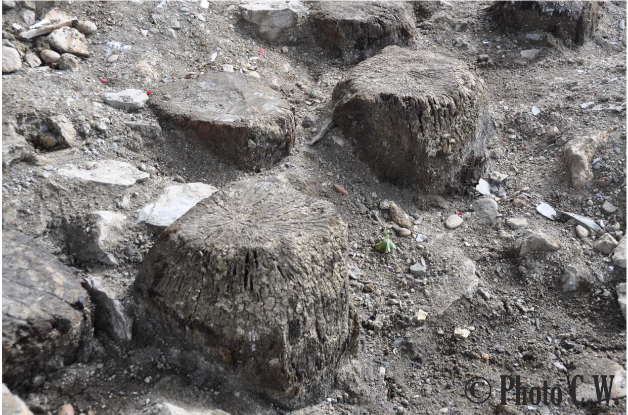
Détail des pieux en fin de rangée vers l'amont. A partir de cet endroit, la rangée oblique très fortement à gauche vers l'Av. Churchill, concrétisant l'arc de cercle.
