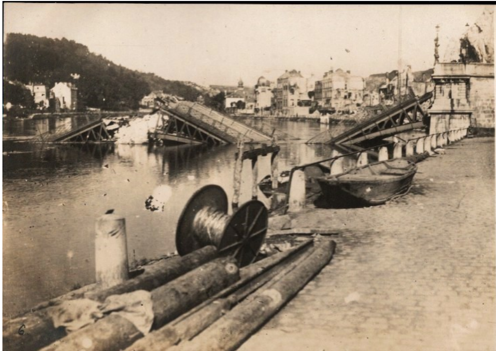
Le pont détruit, vu d'un angle inhabituel.
