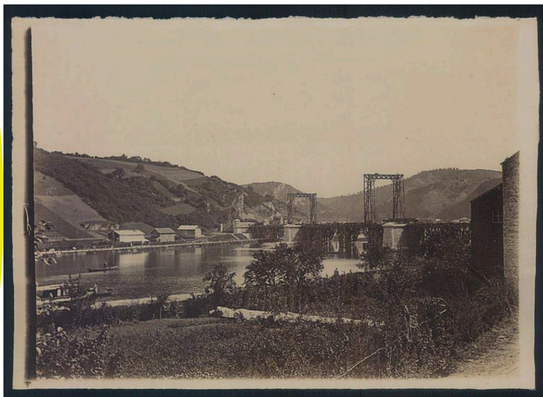
Construction du pont ferroviaire d'Anseremme en 1897. Les bâtiments en bois situés sur la gauche auraient hébergé les ouvriers travaillant au pont (communication de Stéphane Hecq).
