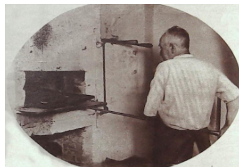
Nous arrivons devant le four au moment où les ouvriers y déposent deux platines
