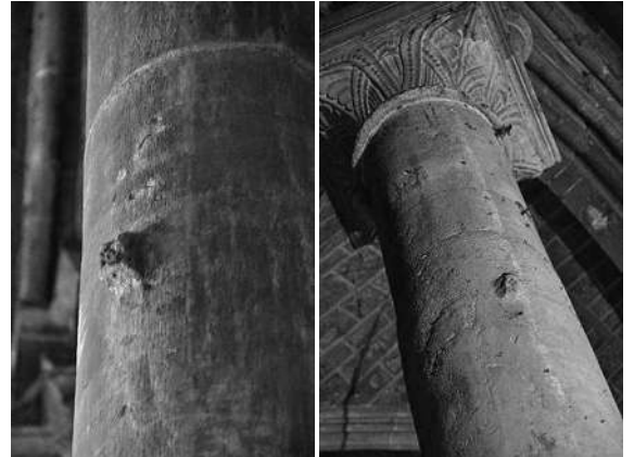
Tenons de colonne (Photos CW)
