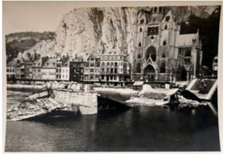
Pont détruit, photo du 25/6/1940
