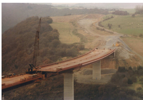
Construction du viaduc
