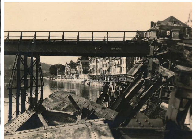
Au niveau du pont détruit. (Photo allemande).
