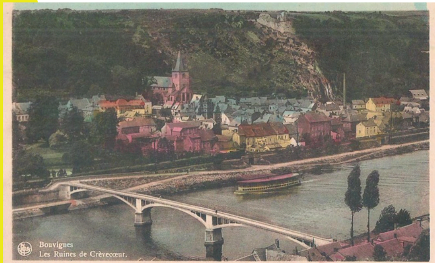
La passerelle après 1922
