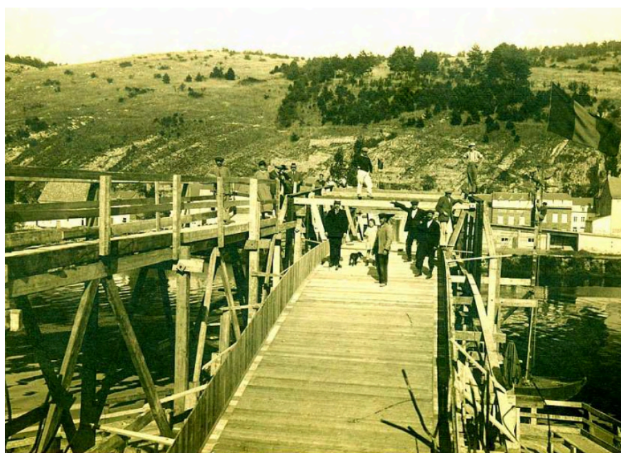
Coffrage pour le béton terminé. Les personnes sont endimanchées et le drapeau belge flotte. Coll. Ph. Maranzan.
