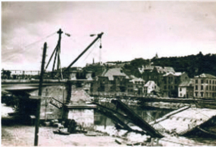
Pont de Dinant démoli.
