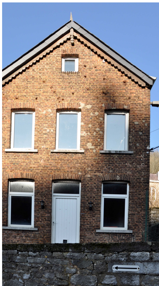
Photo de la façade de la maison
